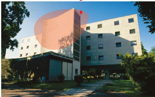
Projeto: Pavilhão Sulço Arquiteto: Le Corbusier Localização: Cidade Universitária, Paris, França Ano: 1931
