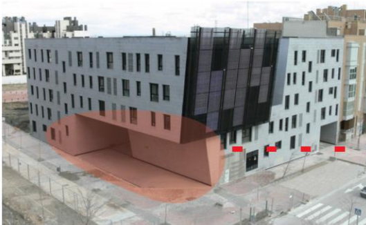
Projeto: Vallecas 48 Arquitetos: Auriens Arquitectura Localização: Madrid, Espanha Ano: 2006
