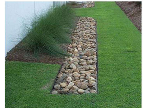
(a) Trincheira de infiltração
