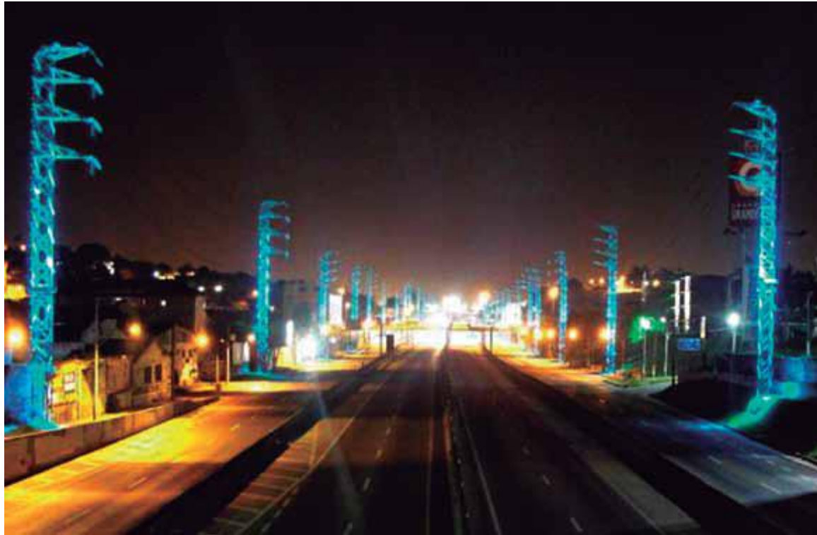
Torres de Energia, São João de Meriti
