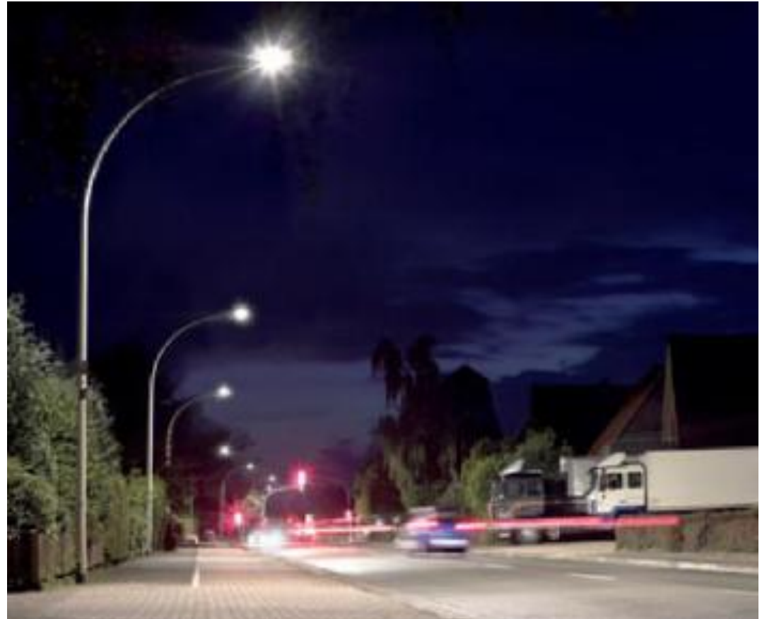
LÂMPADA – HPI Plus Aplicação em iluminação em vias de tráfego. São lâmpadas de vapor metálico que necessitam de reatores para sistemas metálicos.
