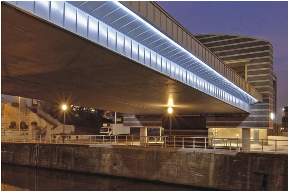
Ponte do canal Charleroi – Bruxelas, Bélgica. Iluminada por 92 LED brancos de alta potência com uma abertura de 120°.
