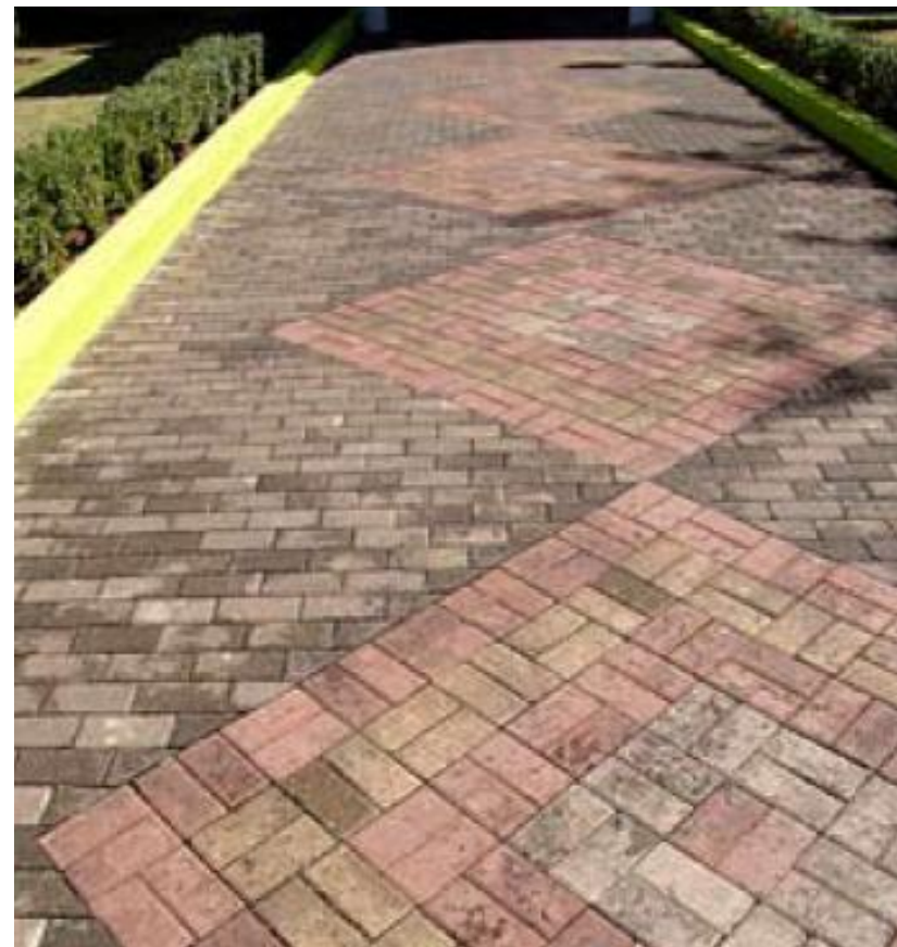
Aplicação de piso intertravado em peças de concreto
