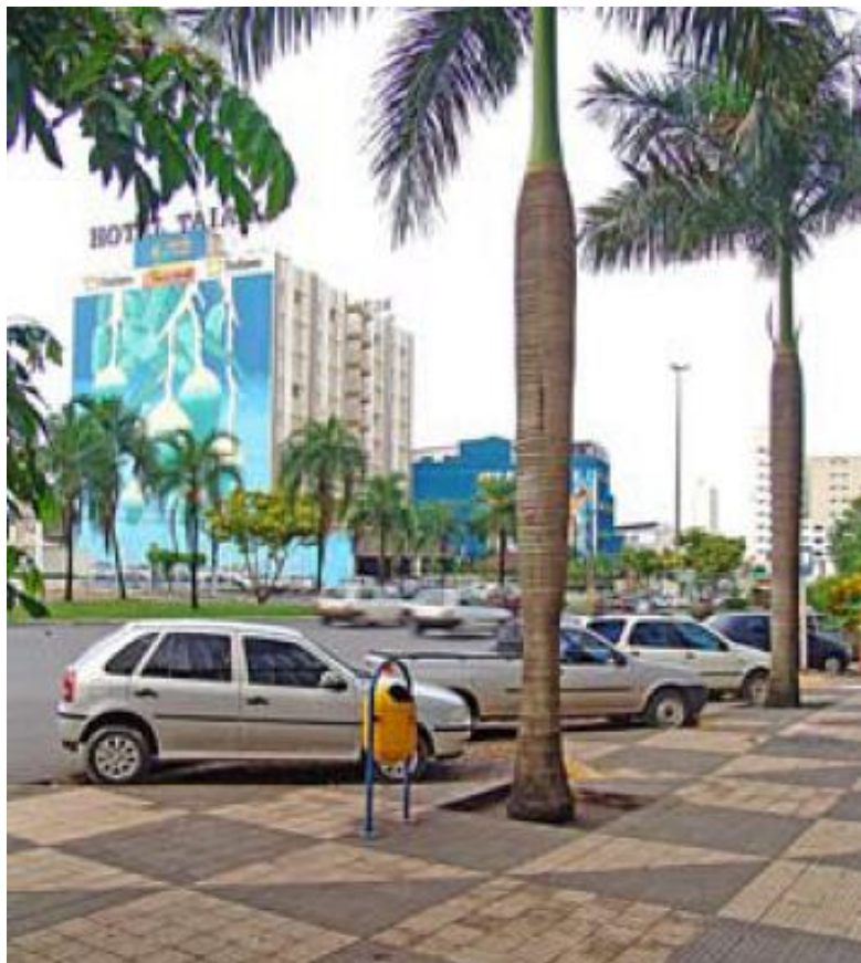
Aplicação de piso intertravado em peças de concreto
